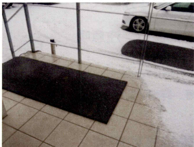
事務所出入口のヒートマットの設置例
